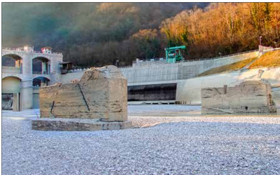
Med čiščenjem jezusa se na mestu, kjer je bil maja 1917 začasni most, pojavili temelji mostu, zgrajenega septembra 1917. (foto: David Erik Pipan)
