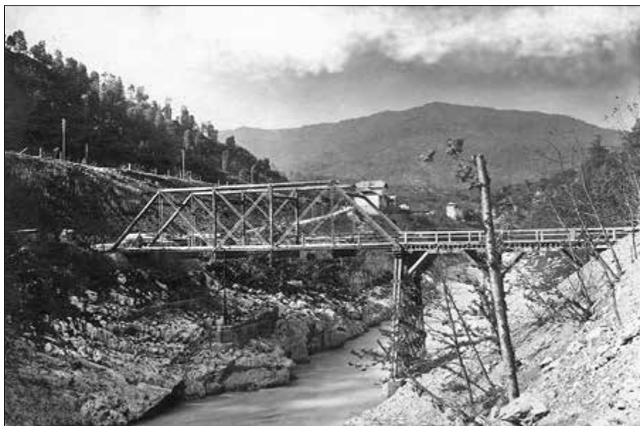
Most v Avčah, zgrajen med 11. soško ofenzivo (zbirka Egona Valantiča)
