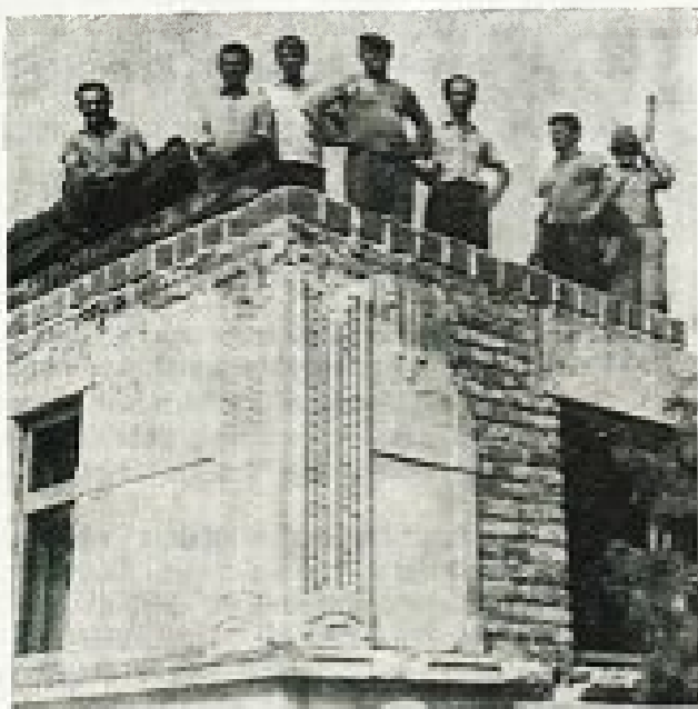
Pomoč pri gradnji in obnavljanju hiše. Nedelica 66 Foto: M. Makarovič
