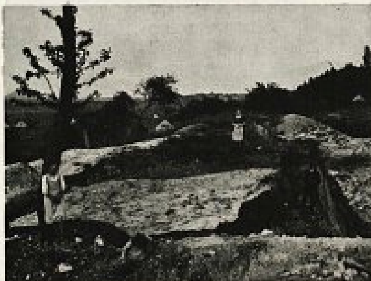
Sl. 4. Zid z ometom (na desni).
