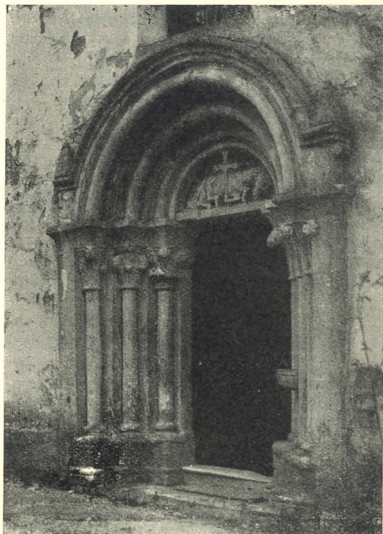
Spital — glavni portal (Foto: M. Zadnikar)
