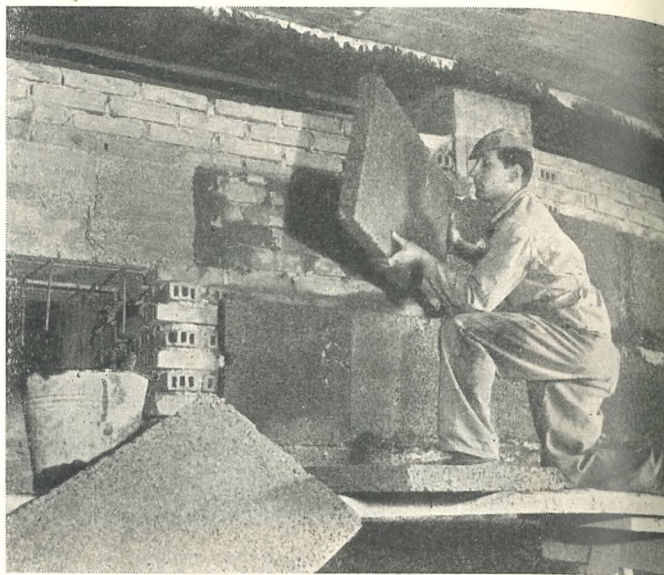
Montaža plutove izolacije — izdelek tovarne »PLUTAL«
