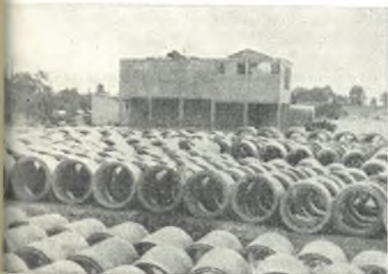
Betonarna v izgradnji s kapaciteto 40.000 m 3 betona letno
