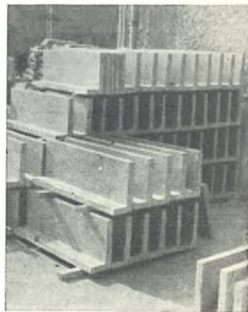
Montažna stopnišča ca. 1000 stanovanj letno
