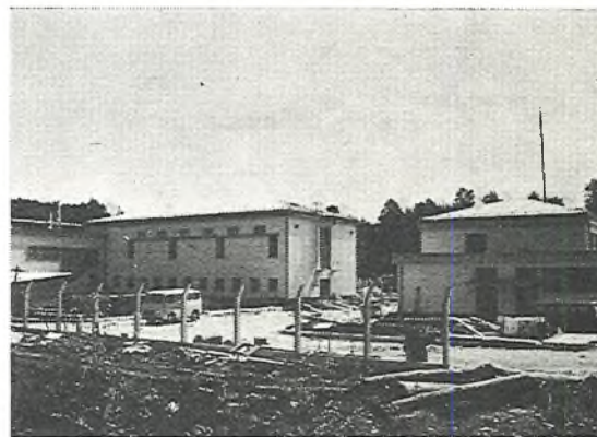
RTP Logatec. Upravna stavba in 20 KV stikališče z bočne strani
