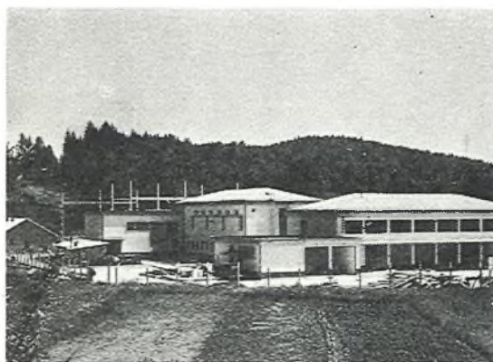
RTP Logatec. Upravna stavba, 20 KV stikališče in komandni prostori s čelne strani
