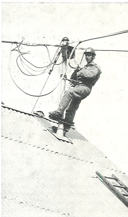
Montaža samonosnih vodnikov na strešno stojalo
