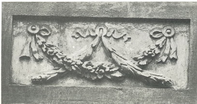
Nekdanja Englerjeva hiša, stukaturni okras fasade
