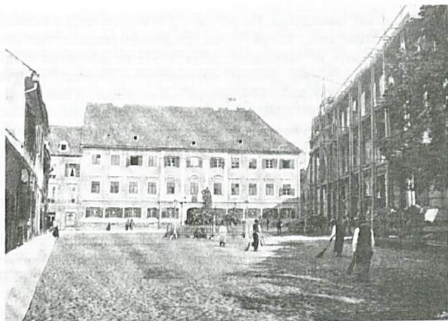
Gradnja Narodnega doma (1895)
