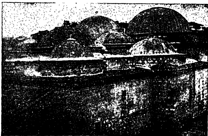
Kopališče (hamam) v Skopju, zunanost
